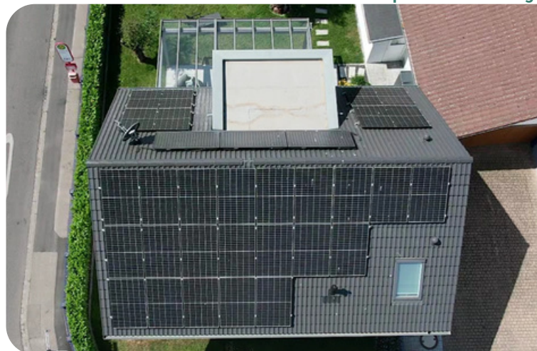
Referenz: 12 kWp Photovoltaikanlage mit 10 kWh Speicher in Freiburg
