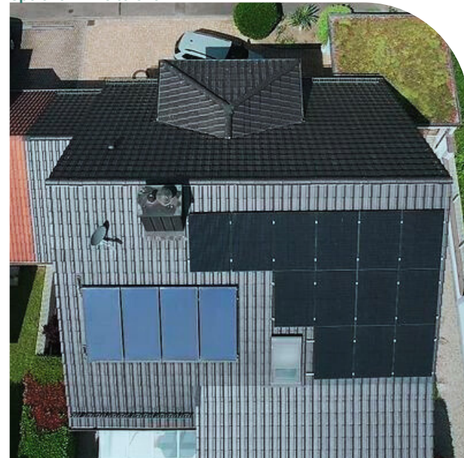
Referenz: 6 kWp Photovoltaikanlage mit 5 kWh Speicher in Heitersheim
